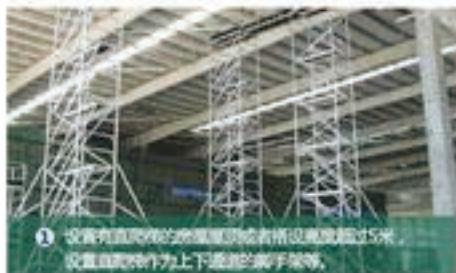
① 设置有脚手架必须设置直梯或者搭设高度不超过5米，设置直梯作为上下攀爬的着手攀梯。
