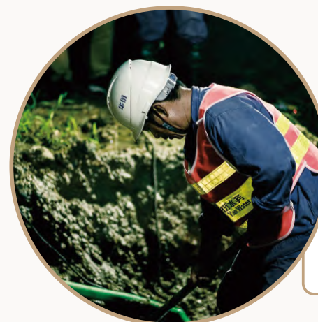
夜间管网抢修
