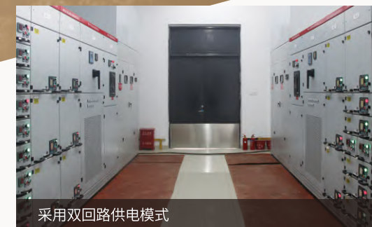
一台变频控制柜控制一组电机水泵
