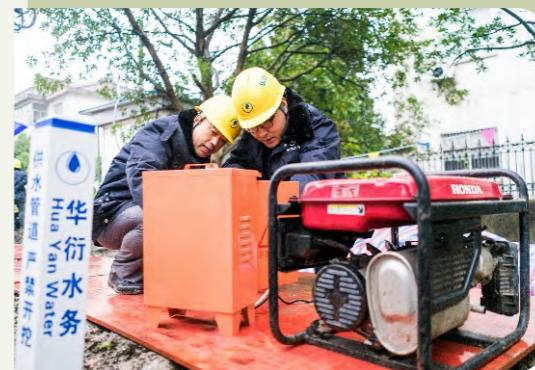
项目具体内容是在吴江华衍水务的退役供水管中进行非开挖内衬燃气管施工，施工长度共380米。与以往维修自来水管时路面被全部挖开的景象不同，施工现场只挖了几个小型作业坑，施工人员将新的燃气管道穿进退役的供水管道中，并新旧管道之间进行水泥压力注浆。
