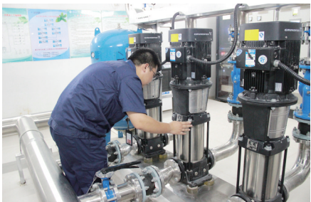
二次供水泵房检查维护
