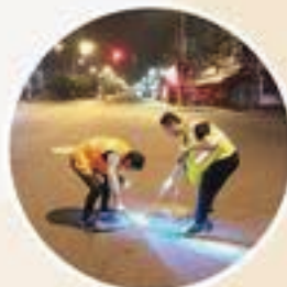
▲ 检漏人员在盛泽南环路用听漏棒检测到水流声音，用钩子打开井盖观察
