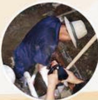
▲ 黄林清平西区口径75单元管维修
