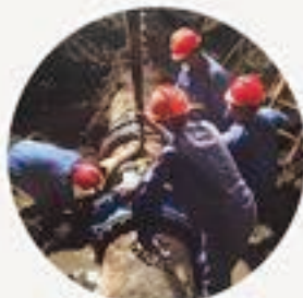
▲ 南康DN600闸门老化更换
