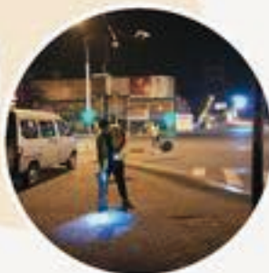
▲ 检漏人员在盛泽西环路清凉春天附近查漏
