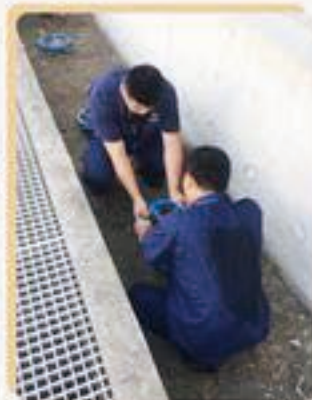
▲ 高峰供水期间开启沉淀池排泥阀门排泥
