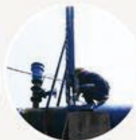
▲ 七都西亭子桥排气阀维修
