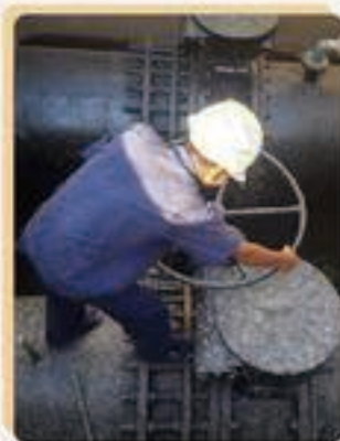
▲ 高峰供水前湖涌台深度处理工程管道接驳
