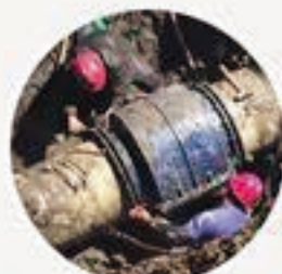
▲ 望星增压泵站对国南路DN600玻璃钢管抢修
