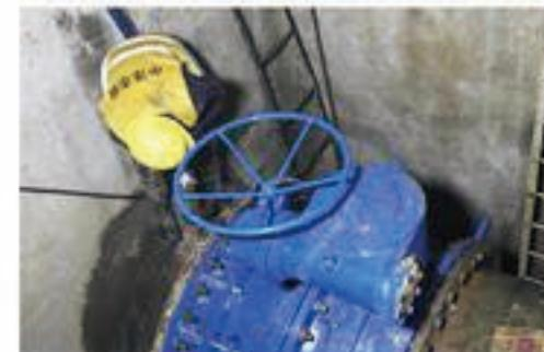
2017年11月15日,吴江华衍水务庙港水厂开展连接深度处理综合池管线停水接拢工作,此次接拢内容为更换滤池出水管DN1400蝶阀2个、滤池与深度处理综合池新旧管线碰接点4个。
