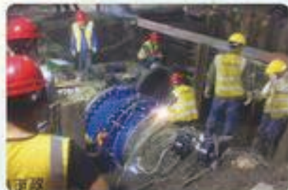
2017年4月 安装工程全面开工。
