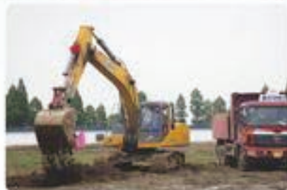
2016年6月 桩基工程全面开工。
