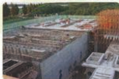
2017年3月 土建工程全面开工。
