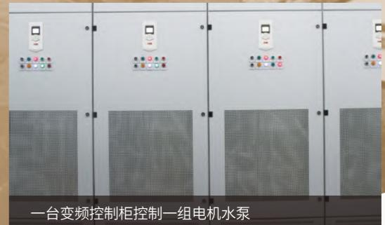
一台变频控制柜控制一组电机水泵
