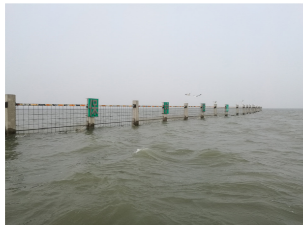
◎加强水源地运行维护
