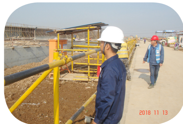
◎施工安全审核
