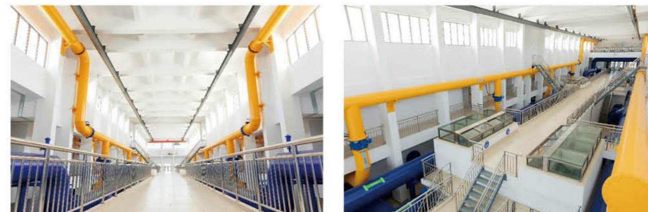
©庙港水厂深度处理全覆盖工程
