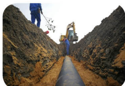
◎农村供水管网改造
