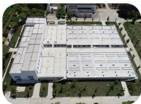
◎清源华衍水厂深度处理升级改造
