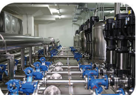
◎老旧小区二次供水改造
