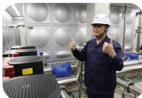
◎“BIM设计+工厂化预制”标准化泵房
