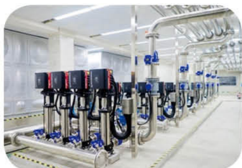
◎“BIM设计+工厂化预制”标准化泵房
