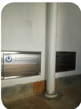
◎老旧小区供水管网改造
