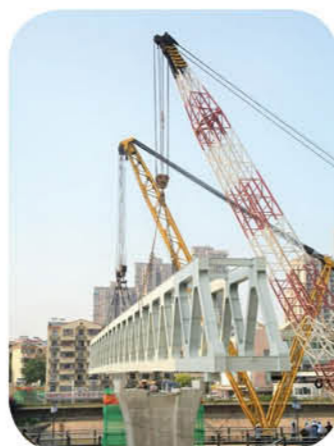
◎芜湖华衍健康路水厂引水工程
