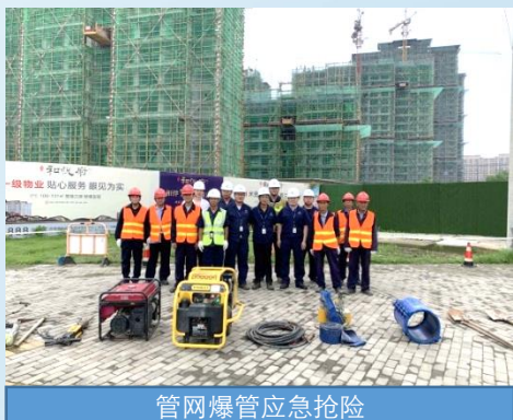
管网爆管应急抢险
