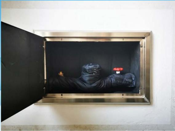
水管网，严格按照防寒标准进行管网材料及埋深设计施工，对用户水表进行保温套保温或者填沙保温。截至目前，已完成老旧小区改造 295 个，惠及居民 7.1 万户；161 个村完成农村供水管网改造，惠及居民 5.1 万户，以高质量建设夯实防寒保供基础。
