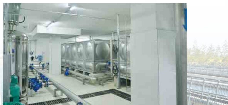
◎二次供水泵房整体构造
